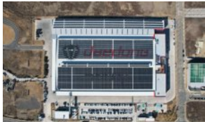
대동모빌리티 태양광 발전소
